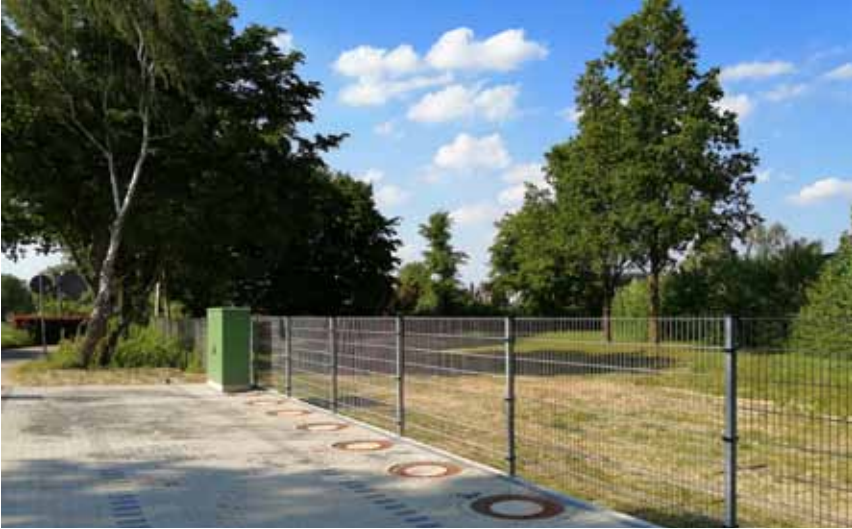
Regenwasser-Rückhaltebecken an der Straelener Straße
