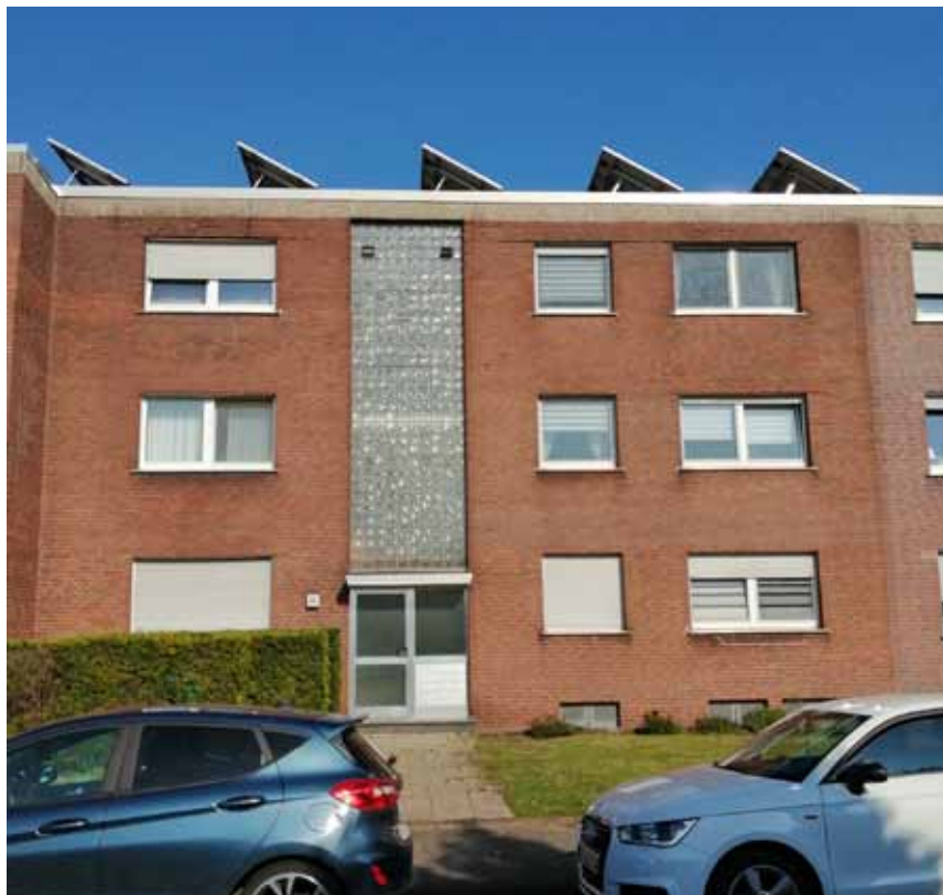
Photovoltaik-Anlage auf dem Dach – Seltener Anblick im Hagelkreuz Foto: Ulrich Buchholz
